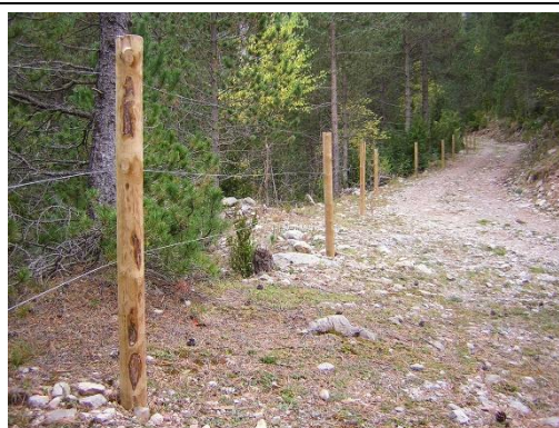
Tancat elèctric i tancat que permet el pas de la fauna.
